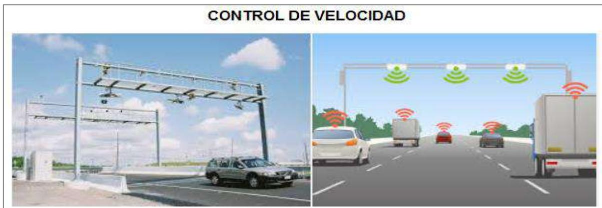
**Figura 2.54** Ejemplo de pórtico con dispositivos de medición de velocidad como sistema inteligente de transporte (ITS)
